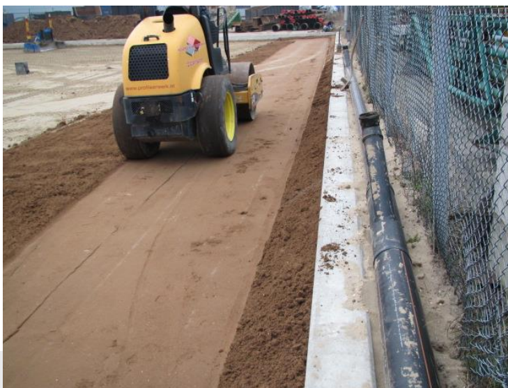
Foto: Aanbrengen van zand-bentonietpolymeergelmengsel.
